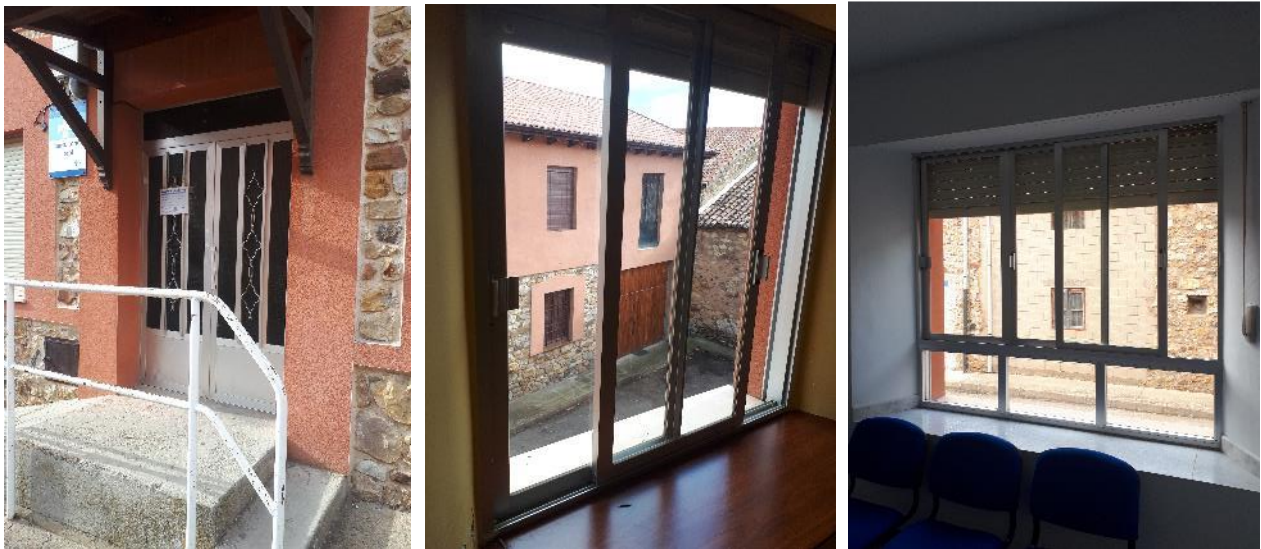
PUERTA Y VENTANAS ACTUALES EN EL EDIFICIO DE LA CASA DEL PUEBLO
